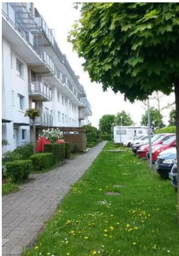
Obr. 28 Chodník s příčným sklonem umožňující odvodnění do prohlubní v trávniku [1]
