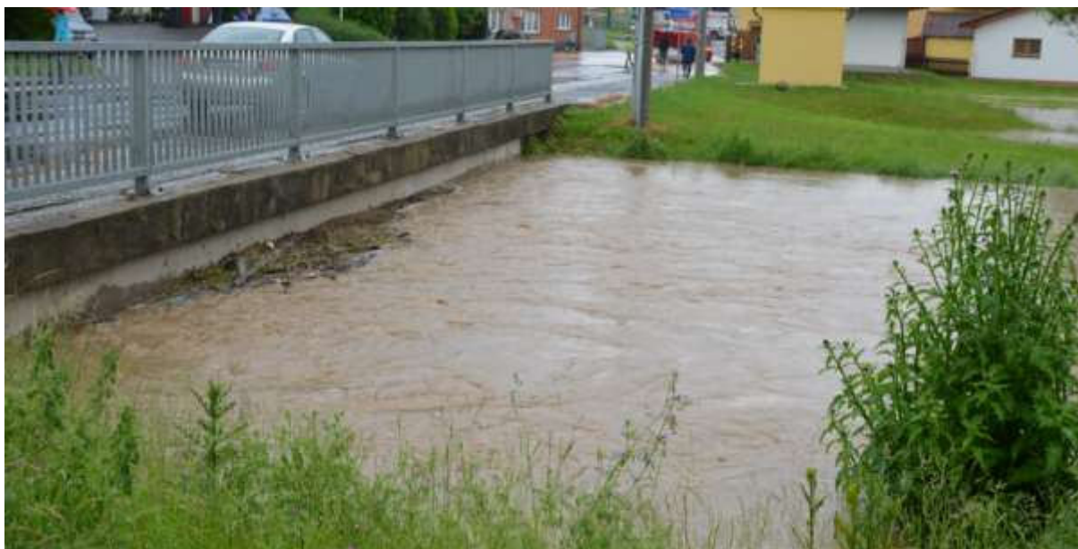
Obr. 23 Zahlcený vtok na silničním mostě na p.č. 59 k.ú. Dolní bobrová Zdroj: Městys Bobrová
