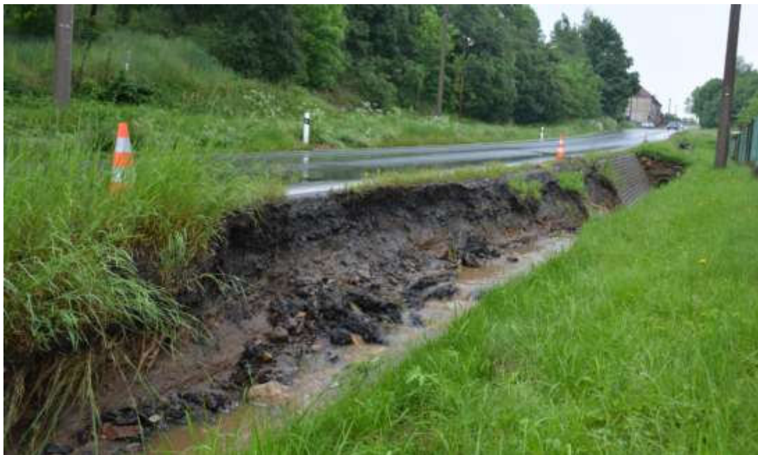
Obr. 17 Poničená část místní komunikace Zdroj: Městys Bobrová
