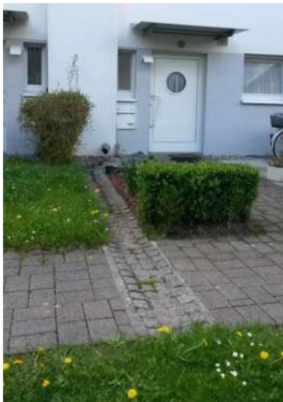
Obr. 26 Zaústění vod z okapu ke vsakování na trávníku [1]
